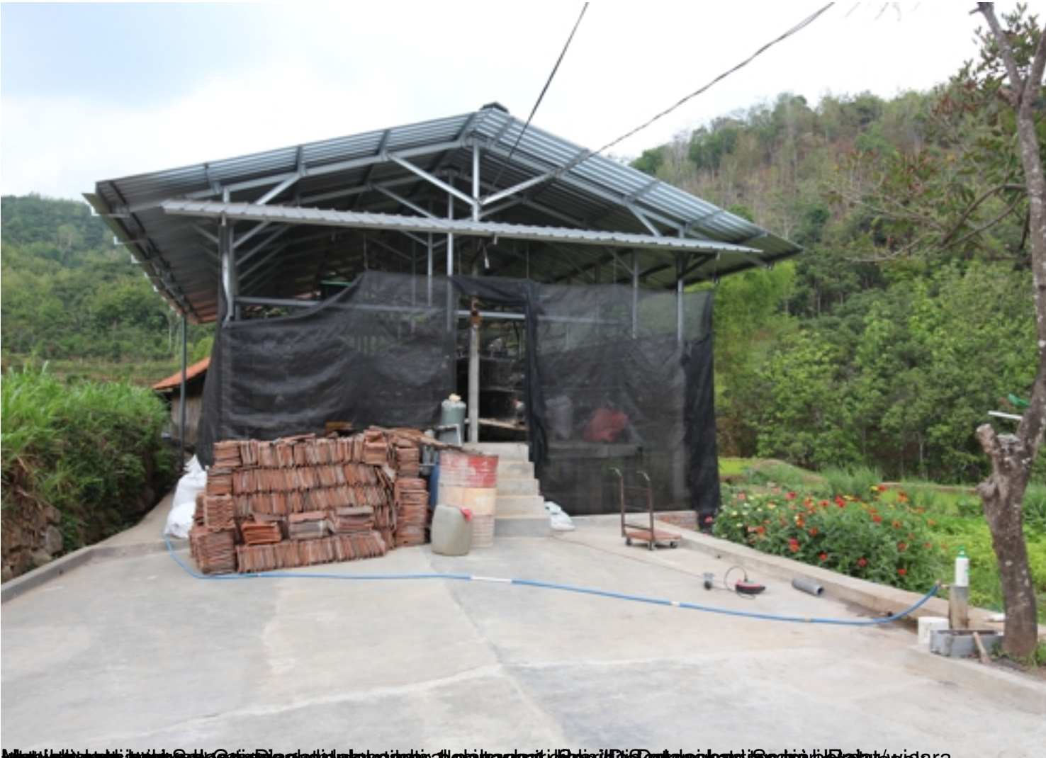
Struktur rumah yang dibangun di atas platform beton yang dilengkapi dengan atap dan dinding yang terbuat dari bahan-bahan yang mudah didapat dan murah.
